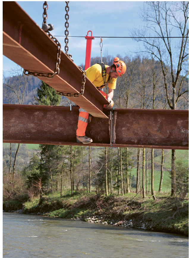
25 Montage einer Stahlkonstruktion mit Sicherung an einer horizontalen Lifeline.
