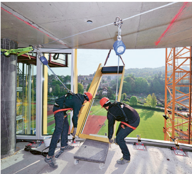
24 Arbeiten an einer Absturzkante.
