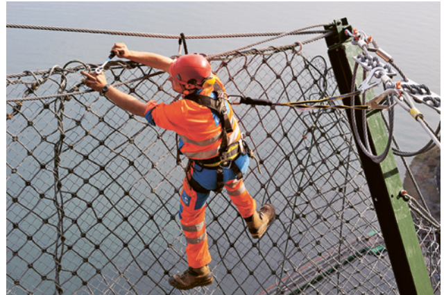
8 Sicherung mit Auffanggurt und Halteseil. Halteseil mit grossem Sicherheitskarabinerhaken zum Einhängen an der Anschlagstelle.
