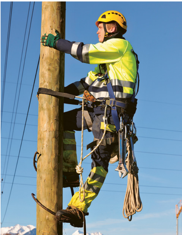
6 Freileitungsmonteur besteigt mit Steigeisen und Masthaltegurt einen Holzmast. Hier ist kein zusätzliches Sturzauffangsystem notwendig.
