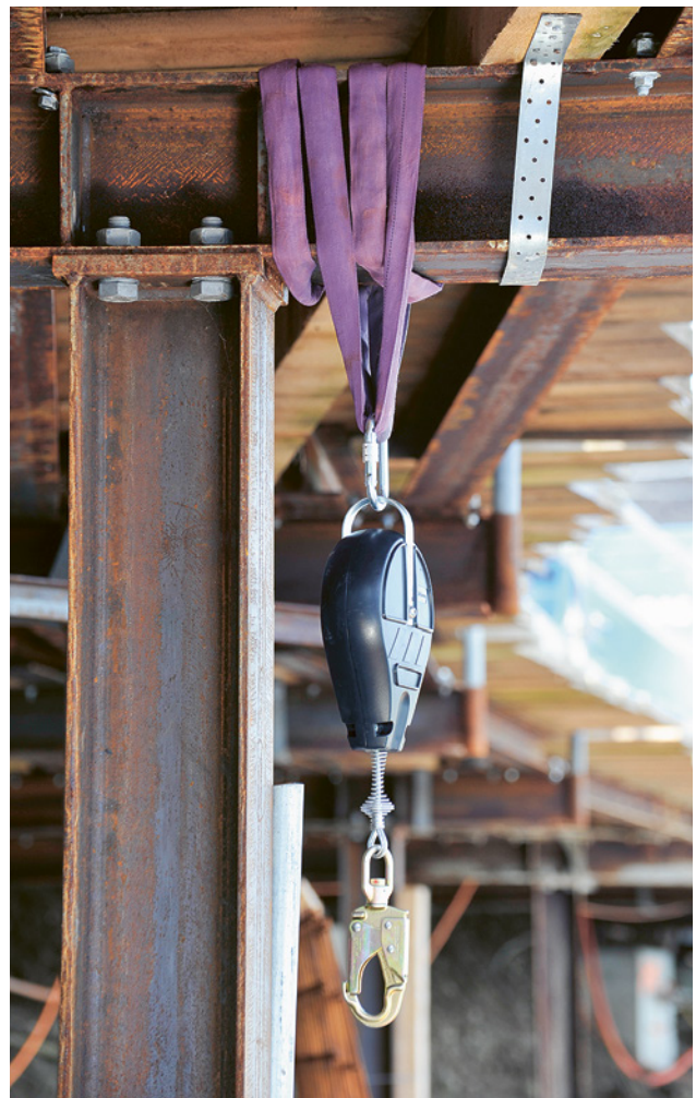
23 Anschlagen des Sicherungsseils an einem tragfähigen Teil einer Tragkonstruktion.
