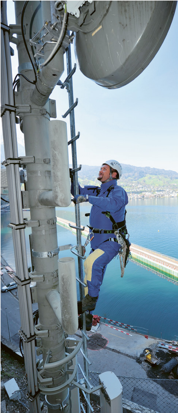
14 Mit einem Steigschutz an der Mittelschiene einer ortsfesten Leiter gesicherter Monteur.
