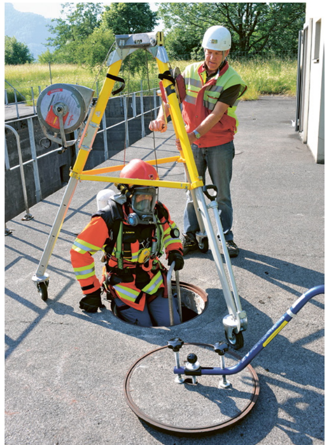
21 Einstieg in einen Schacht über eine Leiter. Sicherung durch Auffanggurt und Höhensicherungsgerät mit Rettungskurbel. Der Eingestiegene kann jederzeit von aussen mit der Rettungskurbel hochgezogen werden.
